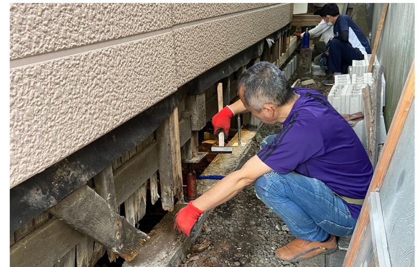
岡館の修築作業には合計11名が参加し、参拝場の畳をめくって床下を補強（写真左、中央）。また、腐食した土台と柱を取り除き、建物の歪みを修正する大掛かりな作業を実施した（写真右）。
