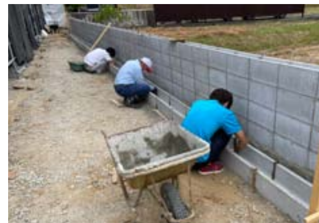
外構作業では、ブロック塀や排水路の設置、石積みなどをすべてひのきしんの手で実施。三密、と熱中症に気を付けながら、慣れない作業を進める。
