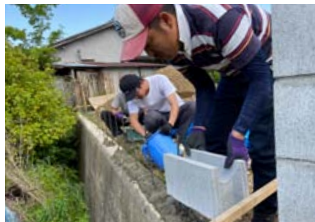
外構作業では、ブロック塀や排水路の設置、石積みなどをすべてひのきしんの手で実施。三密、と熱中症に気を付けながら、慣れない作業を進める。
